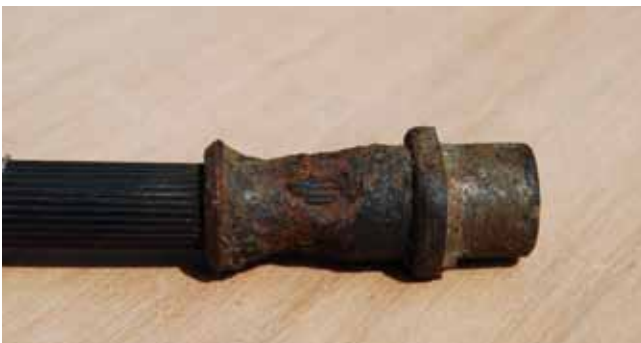
Wartel gedeeltelijk verdwenen als gevolg van corrosie.
